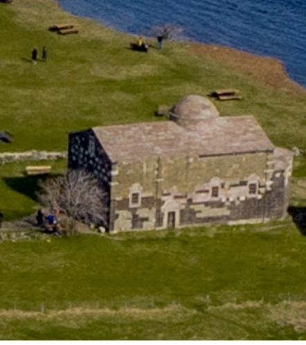
**Çatı Örtüsü:** Naos mekanının çatı örtüsü açılı ve taş kaplama şeklinde olup, ortasında yuvarlak kubbe yer almaktadır. Kubbede pencere yer almamaktadır. Kubbenin silindirik yüzeyinde pencerenin olmayışı bu tip yapı fonksiyonlarında pek görülmez. Kilise çatısının tüm cepheleri düz silme şeklinde çevrelenmektedir.
