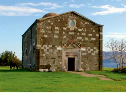
Kilisenin ana giriş kapısı batı cephesinin ortasında yer almaktadır. Kapı dikdörtgen formlu ve lentoludur. Lentonun ve bu süslemenin üzerinde dikdörtgen bir alan oluşturulmuştur. Bu alanın ortasında sekizgen formlu içi boş bir çerçeve olup iki yanında kabartma olarak işlenmiş birer balık figürü yer almaktadır.
