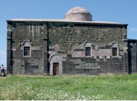
Güney cephede üç pencere bir kapı yer almaktadır. Pencereler; dikdörtgen formlu ve lentolu olarak yapılmışlardır.
